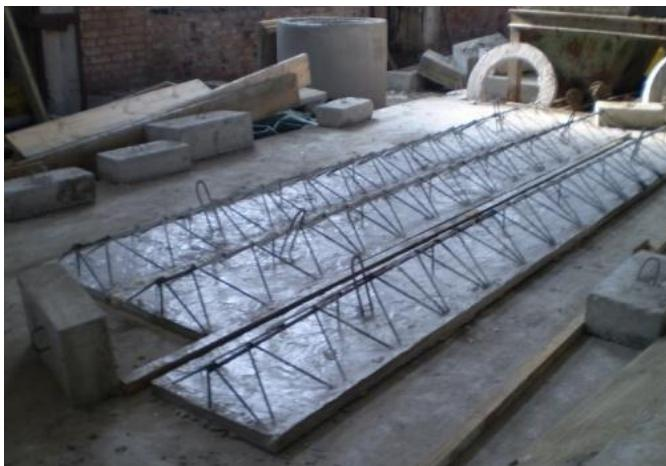
Рис. 2. Сборно-монолитные перекрытия с использованием пенобетона
