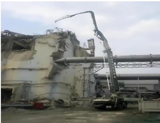
Рис. 4. Роботизированная рука для сноса и транспортировки во время уборки руин атомной электростанции «Фукусима-1»
