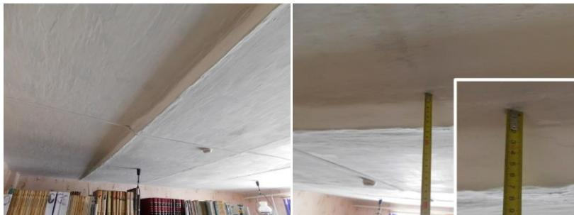
Рис. 1. Прогибы ячеистобетонной панели перекрытия
