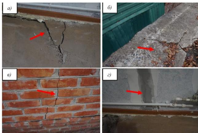
Рис. 2. Характерные повреждения конструкций здания:
