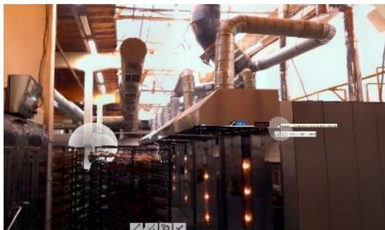
Рис. 7. Указание размера местного отсоса вытяжной системы, выполненного в облаке точек
