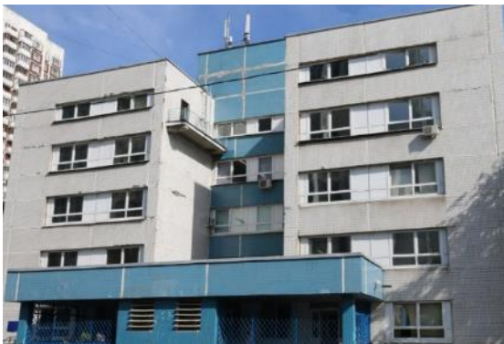
Рис. 1. Фасад здания в осях 11/А-И
