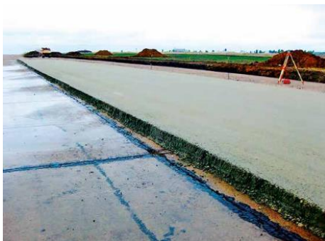
Рис. 1. Укладка рулонного бетона
