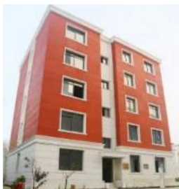
Рис. 3. Жилой дом, возведенный компанией WinSun
