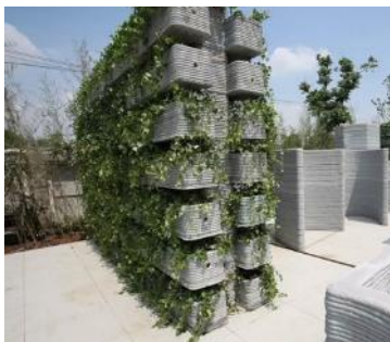
Рис. Бетонная ландшафтная стена, напечатанная на 3D-принтере, WINSUN
