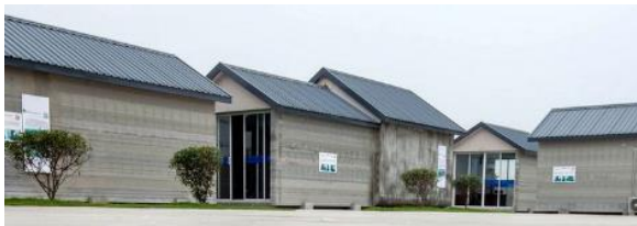
Рис. 2. Бетонные дома от WinSun
