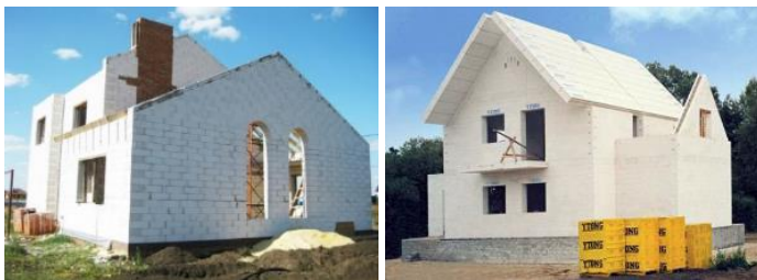
Рис. 2. Использование газобетонных блоков при обустройстве кровли
