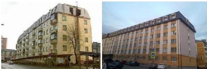
Рис. 1. Примеры реконструированных зданий с надстройкой мансардного этажа с использованием газобетонных блоков
