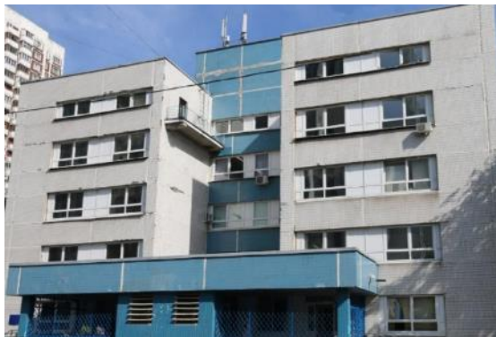
Рис. 1. Фасад здания в осях 11/А-И
