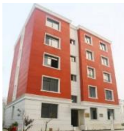
Рис. 3. Жилой дом, возведенный компанией WinSun
