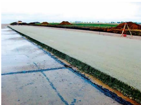
Рис. 1. Укладка рулонного бетона
