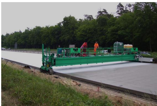
Рис. 1. Нанесение пленкообразующего материала совместно с добавкой-замедлителя на верхний слой уложенного ц/б покрытия
