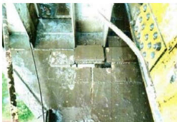
Рис. 5. Вырез в тормозном настиле в зоне колонны
