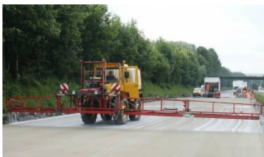
Рис. 4. Нанесение второго слоя пленкообразующего материала после обнажения заполнителей
