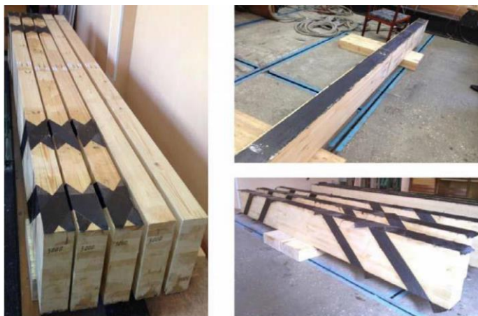
Рис. 2. Внешнее армирование несущих деревянных конструкций композитной лентой
