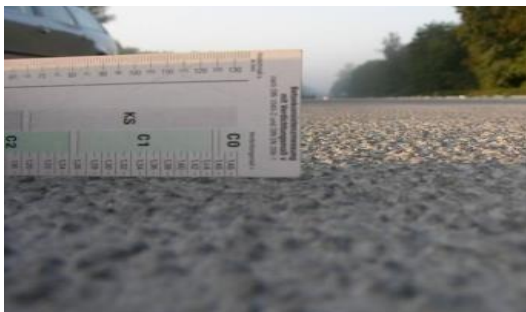
Рис. 3. Текстура поверхности покрытия после обнажения заполнителей
