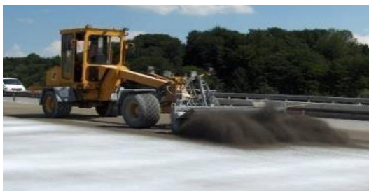
Рис. 2. Обнажение заполнителей с помощью сухой металлической щетки, установленной на дорожной технике
