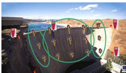
Рис. 2. Измерение контрольных точек на плотине
