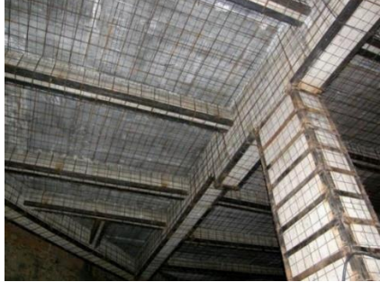
Рис. 1. Усиление монолитных железобетонных плит перекрытия
