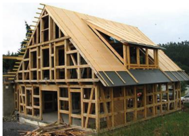
Рис. 3. Каркас фахверкового дома
