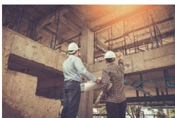
Рис. 1. Визуальный осмотр технического состояния реконструируемых зданий и сооружений
