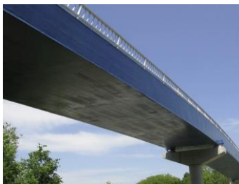
Рис. 5. Усиление моста композитной оболочкой
