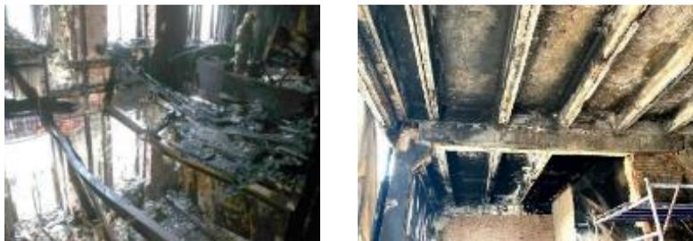
Рис. 1. Разрушение бетонных и железобетонных конструкций пожаром
