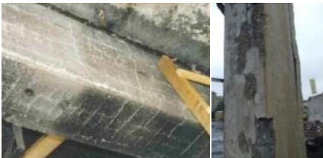
Рис. 2. Дефекты железобетона после пожара: растрескивание и образование отколов
