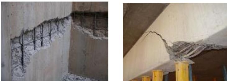
Рис. 3. Дефекты зданий с железобетонным каркасом
