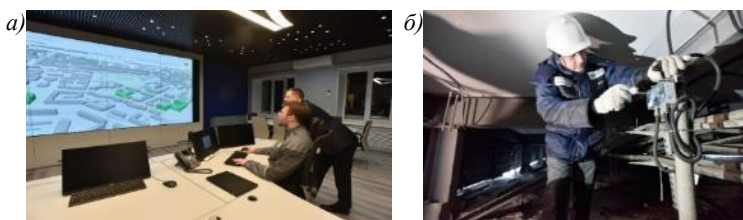
Рис. 4. Система мониторинга ПАО «ГМК «Норильский Никель»: а – диспетчерская Центра мониторинга зданий и сооружений, б – установка датчиков под одним из зданий [9]
