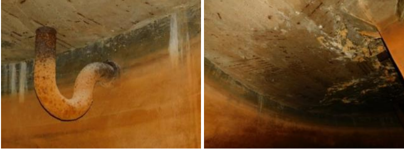
Рис. 2. Состояние внутренней поверхности стен резервуара у плиты покрытия
