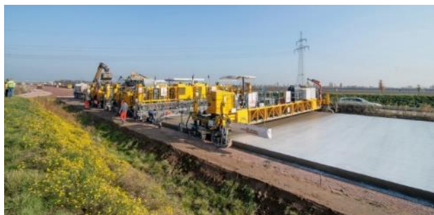
Рис. 1. Двухслойная укладка цементобетонных покрытий бетоноукладчиками компании Wirtgen (Германия)
