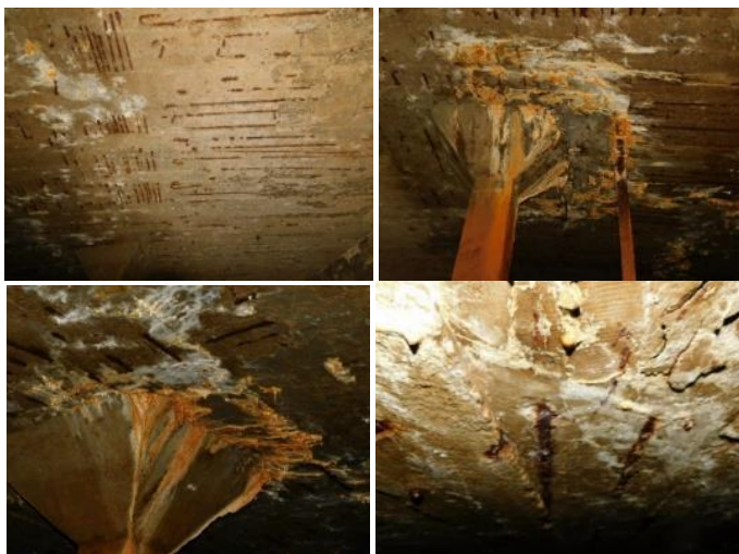
Рис. 4. Техническое состояние плиты покрытия
