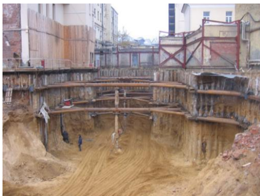
Рис. 4. Пример шпунтового ограждения
