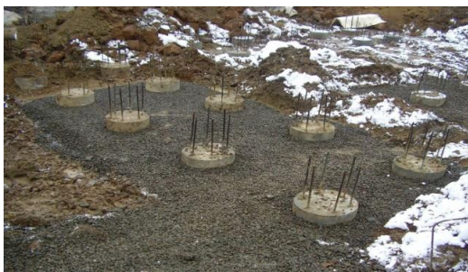
Рис. 1. Установка свай после выемки грунта
