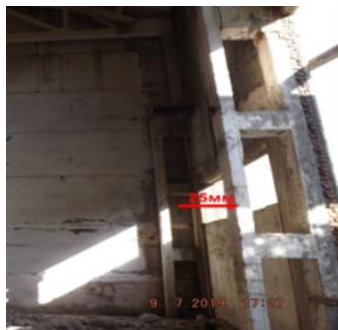
Рис. 2. Отклонение колонн
