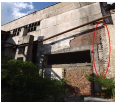
Рис. 1. Вертикальная трещина
