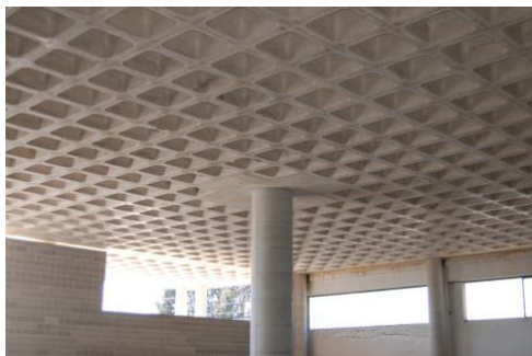
Рис. 3. Монолитное кессонное перекрытие
