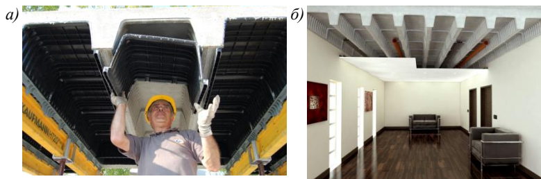
Рис. 2. Монолитное перекрытие, выполненное с помощью опалубки SKYRAIL[2]: a – демонтаж элемента опалубки; б – проведение коммуникаций в надпотолочном пространстве
