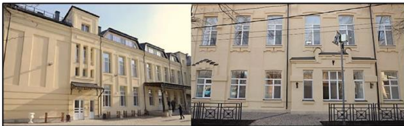
Рис. 2. Учреждение школьного образования гимназия №11 после реконструкции
