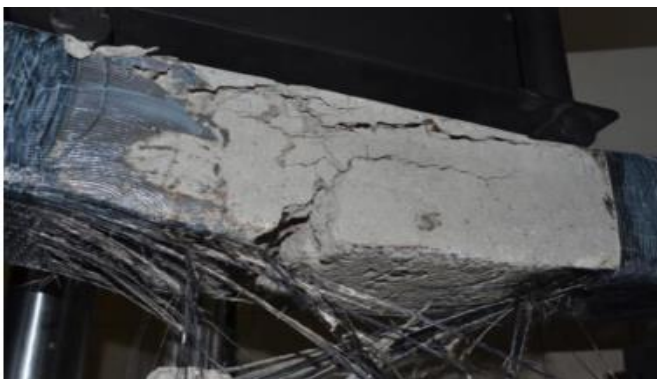
Рис. 2. Разрушение элементов в сжатой зоне с отслоением композитного материала от бетона
