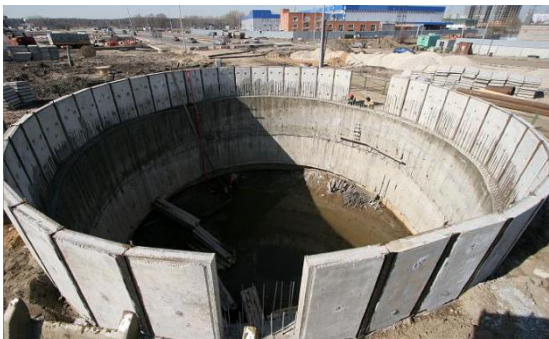
Рис. 1. Погружение сборно-моноконтного опускного колодца
