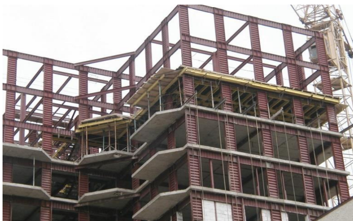
Рис. 3. Рамный каркас 14-этажного жилого дома в г. Алматы с применением двутавров с гофрированной стенкой (2005 г.)
