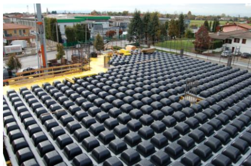
Рис. 4. Установленная опалубка перекрытия системы SKYDOM [2]
