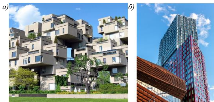
Рис. 1. Здания, построенные из стальных модульных конструкций а – жилой комплекс Habitat 67 в Монреале; б – здание 461 dean в Нью-Йорке
