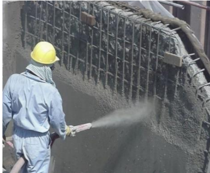
Рис. 1. Процесс нанесения торкретбетона
