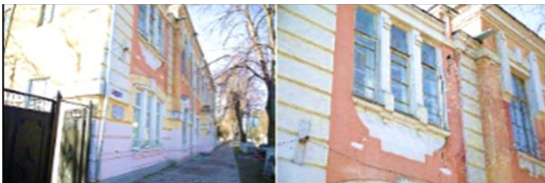
Рис. 1. Учреждение школьного образования гимназия №11 до реконструкции
