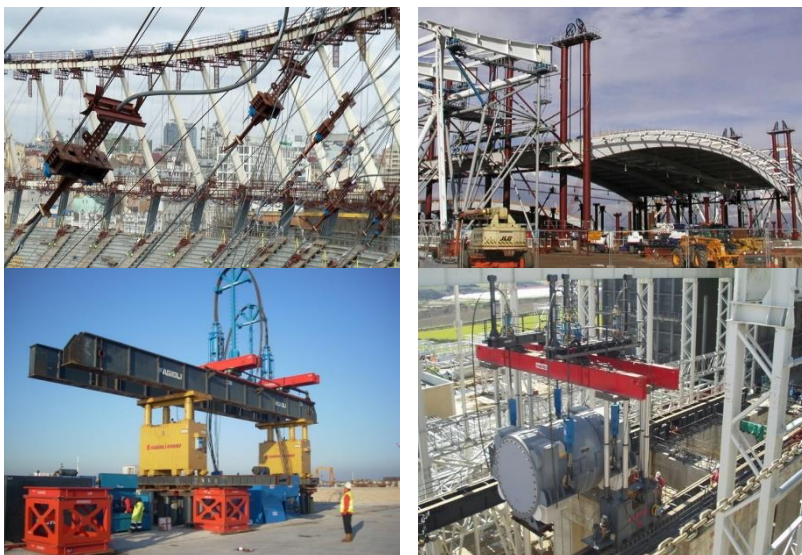
Рис. 4. Использование современных технологий монтажа с помощью телескопических и тросовых гидродомкратных систем различными иностранными фирмами
