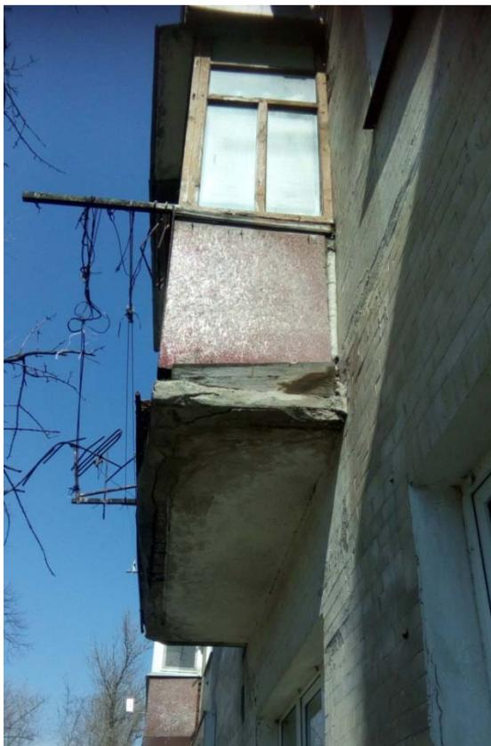
Рис. 3. Отслоение ремонтного защитного слоя балконной плиты
