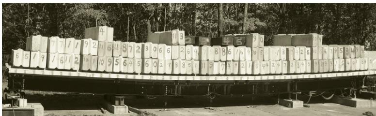
Рис. 4. Схема нагружения испытываемых образцов блоками [13]
