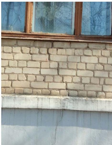
Рис. 2. Трещина в стене здания
