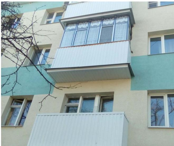
Рис. 1. Отделка фасада и подшивка балконной плиты снизу
