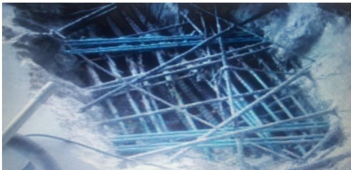
Рис. 1. Разрушения в перекрытии вследствие скопления зерен крупного заполнителя в месте сопряжения с колонной
